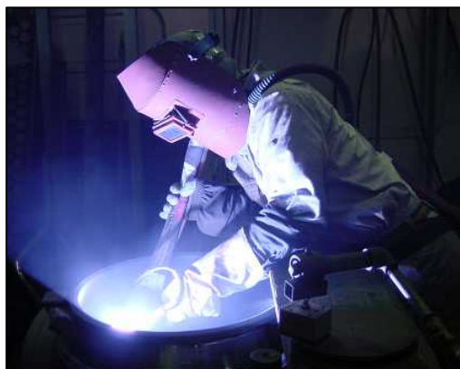
攪拌タンクへプラズマ溶射
