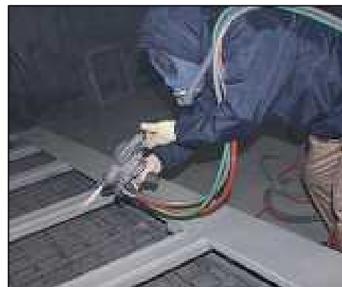
高速道路表示板へ防食溶射
